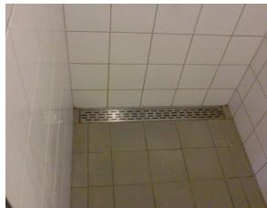
Die Planung basiert auf die wirtschaftliche Variante mit Platzierung aller Objekte an der Wand zum benachbarten WC. Die Wände sind türhoch mit weißen Fliesen 20x20 bekleidet. Zur Abtrennung der Räume werden Leichtbau-Innenwände eingebaut. Die Vorwände werden zur besseren Reversierbarkeit mit HPL-Platten verkleidet. Der Boden hat einen grauen R11 Fliesenbelag und an der Decke findet sich einen neue Metallpaneel-Decke mit Einbauleuchten.
