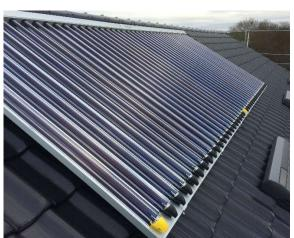
Ersatz von Gasheizung durch Gas-Brennwerttherme mit Solarthermie für Warmwasserbereitung und Heizungsunterstützung.
